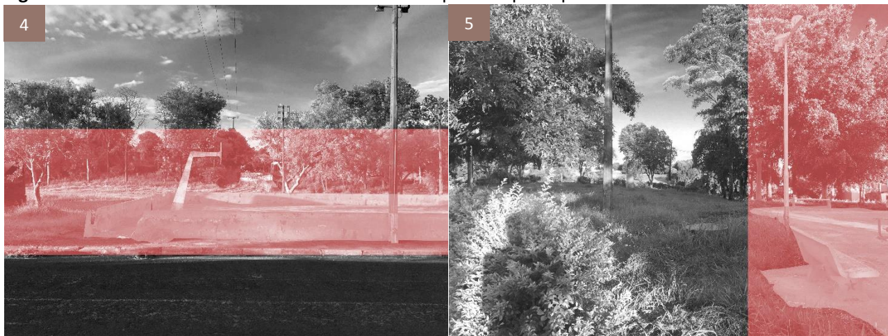
Figura 10 e 11. Estado de abandono da quadra poliesportiva e da academia de idosos.
