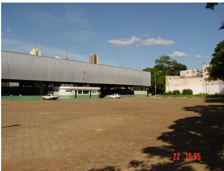
Figura 2. Antiga área utilizada para a disposição final de resíduos sólidos urbano transformada em Parque de Uso Múltiplo
