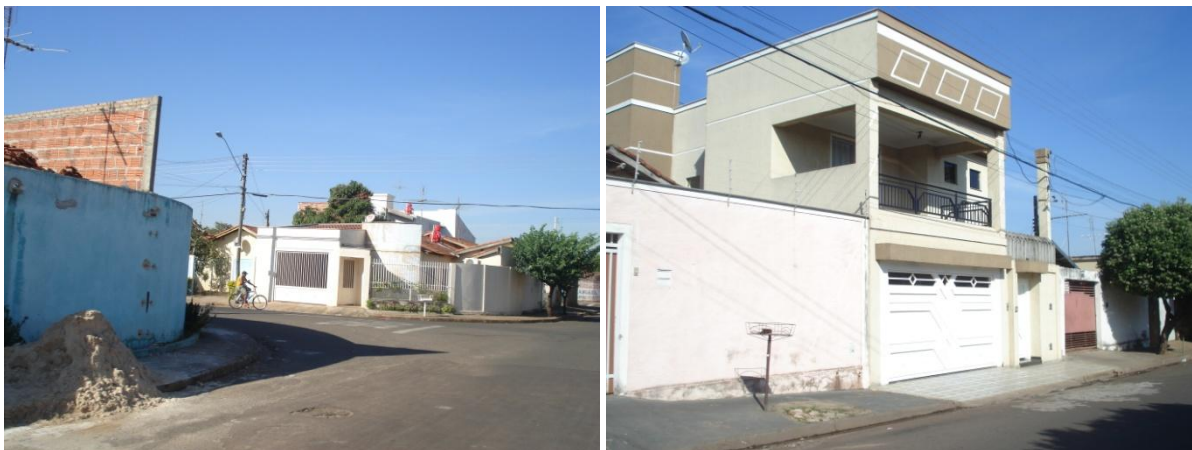
Figura 9 e 10. Araçatuba. Vista do loteamento Hilda Mandarin atualmente. 2012
