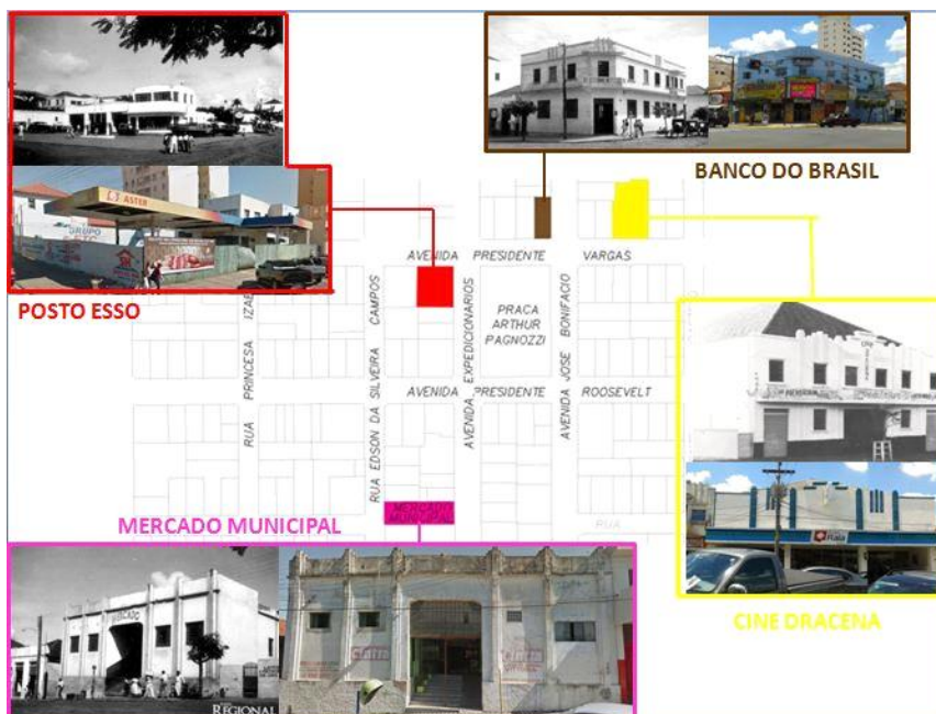
Figura 4. Situação atual das edificações históricas (1950 - 1955) do núcleo urbano inicial de Dracena.
