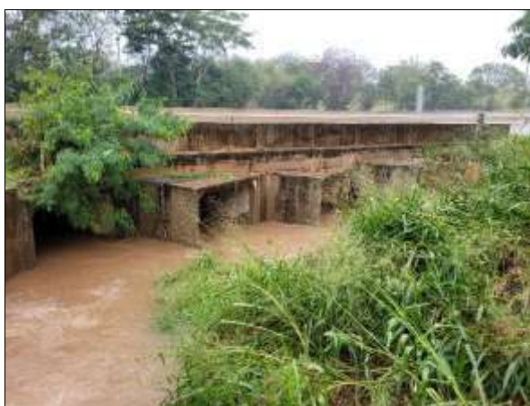
Figura 6. Desemboque do sistema de drenagem da sub-bacia em estudo e travessia da Rodovia Raposo Tavares.
