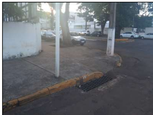
(b) Calçada da esquina sudoeste
