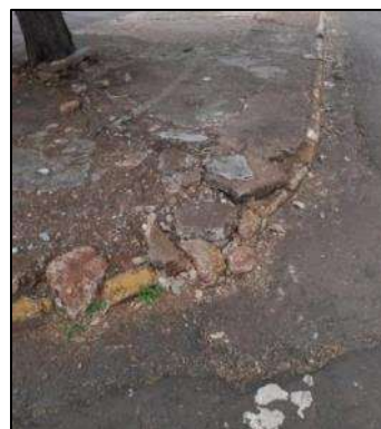
(b) Canteiro central da Rua João Cândido da Câmara
