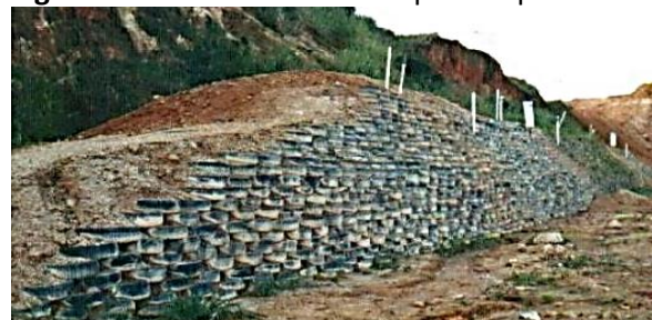
Figura 3. Muro de arrimo do tipo solo pneu.
