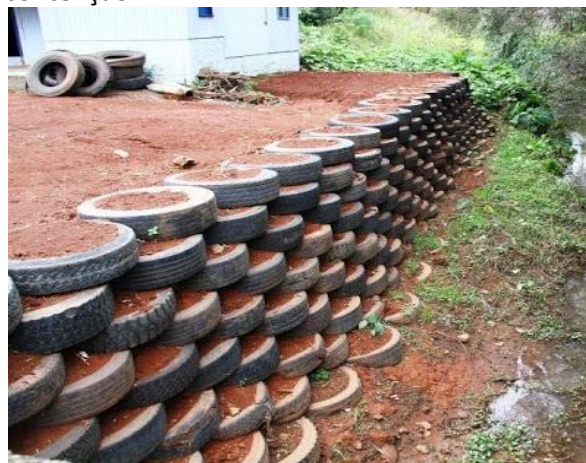
Figura 5. Pneu para construção de muro de contenção.
