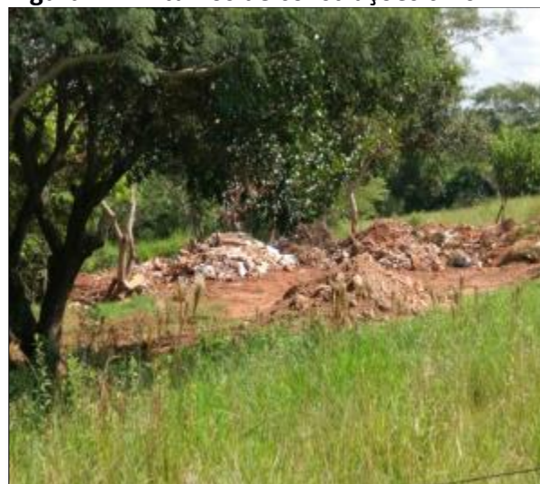
Figura 11. Entulhos de construções civis.
