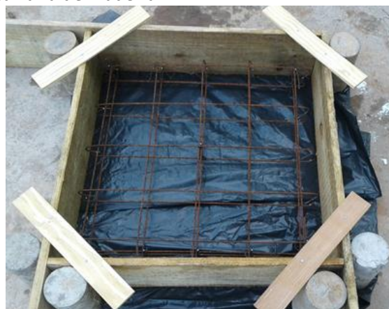
Figura 5. Armadura da laje convencional na caixaria de madeira
