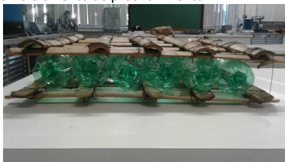
Figura 4. Armação da laje maciça com bambu na armadura positiva e negativa, e garrafas PET como elemento de preenchimento
