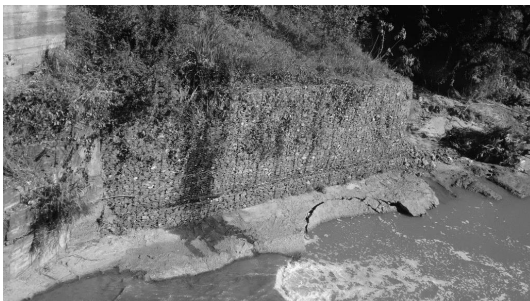
Figura 04. Muro de gabião no campus II da Universidade do Oeste Paulista.
