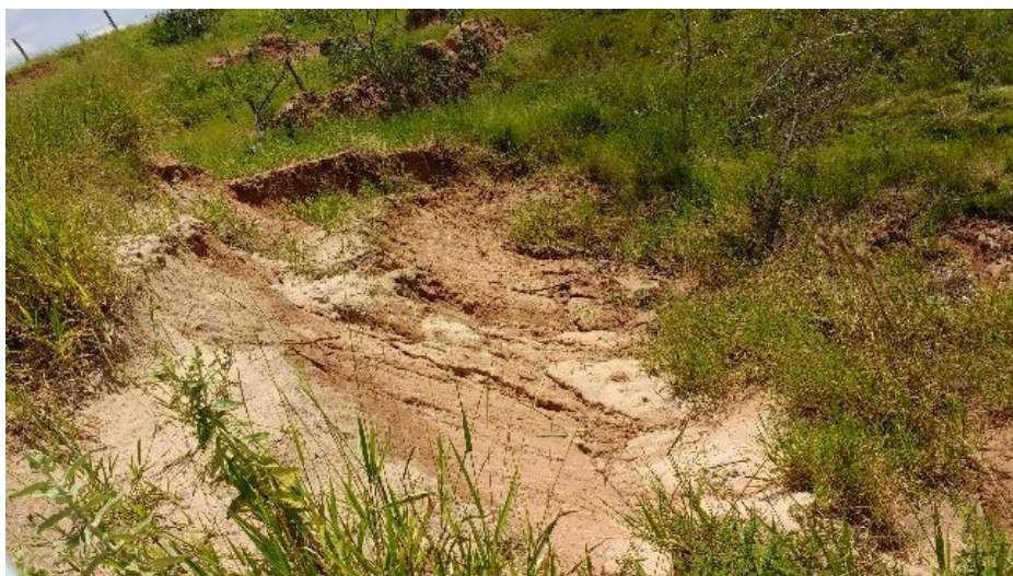
Figura 2. Solo exposto suscetível à erosão. Fonte: Autora (2015).
