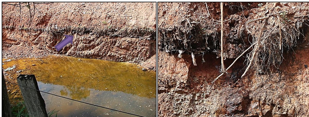
Figura 3 e 4. Lençol freático exposto pela abertura de vala para o depósito de resíduos sólidos.
