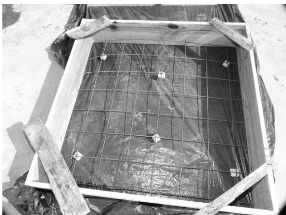
**Figura 5:** Fôrma com tela em Aço 4 mm inferior, incluindo calços.
