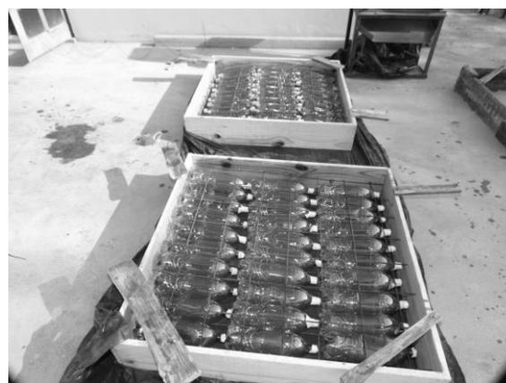
**Figura 8:** Armação e PET's dispostas em Fôrma de Madeira Pinnus para posterior concretagem
