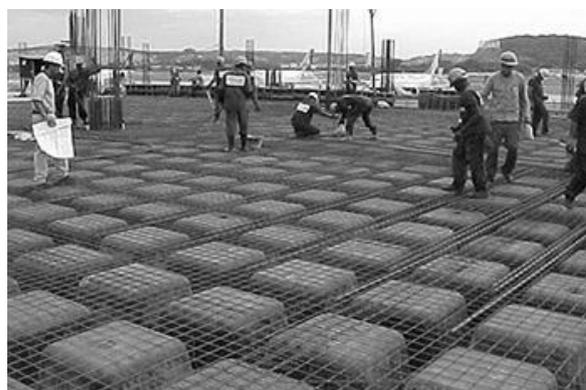
**Figura 1.** moldagem de laje nervurada com utilização de moldes
