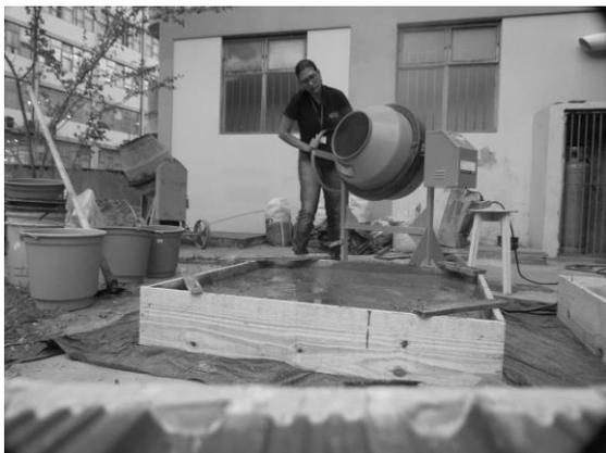
**Figura 9:** Concretagem do Protótipo 1
