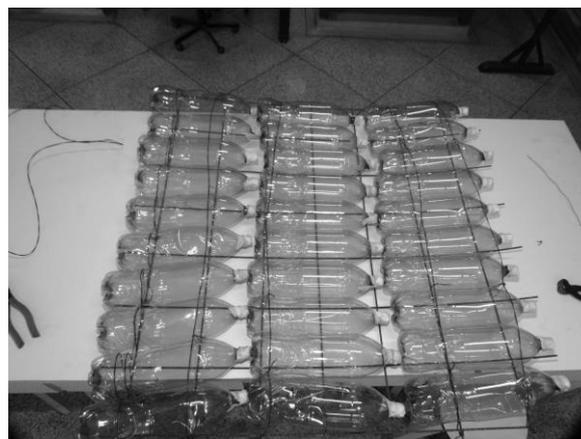
**Figura 7:** Garrafas PET amarradas à Armação superior em Aço 4 mm
