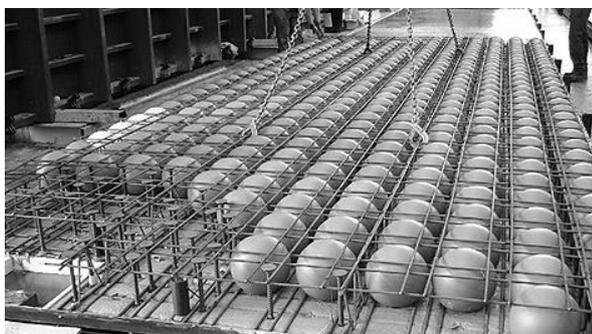
**Figura 2.** moldagem de laje nervurada com utilização de bolas plásticas
