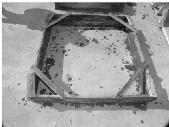
**Figura 3:** Fôrma em Madeira Pinnus para concretagem de protótipos
