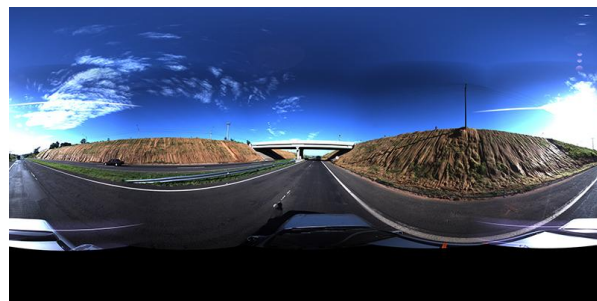
Figura 1. Exemplo de imagem 360º de um trecho de rodovia.
